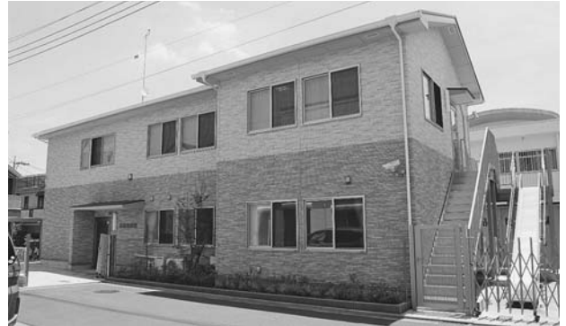
新園舎 平成29年4月スタート 打越保育園裏側
